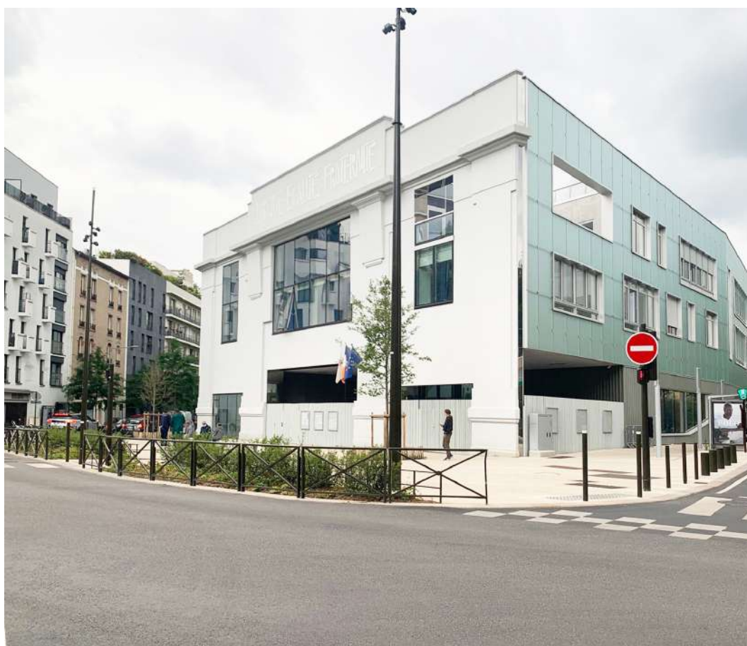
Lycée du Trapèze, Boulogne-Billancourt (92).
